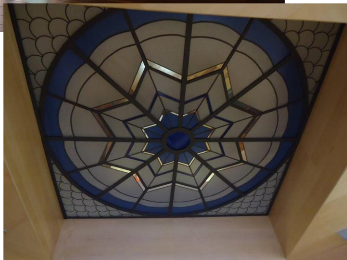
Vista de la galería acristalada (arriba) y de una de las claraboyas emplomadas que la decoran (derecha).
