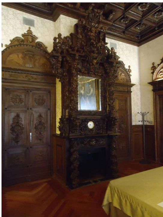
DERECHA : Una de las puertas descuadradas por el peso de la chimenea.
