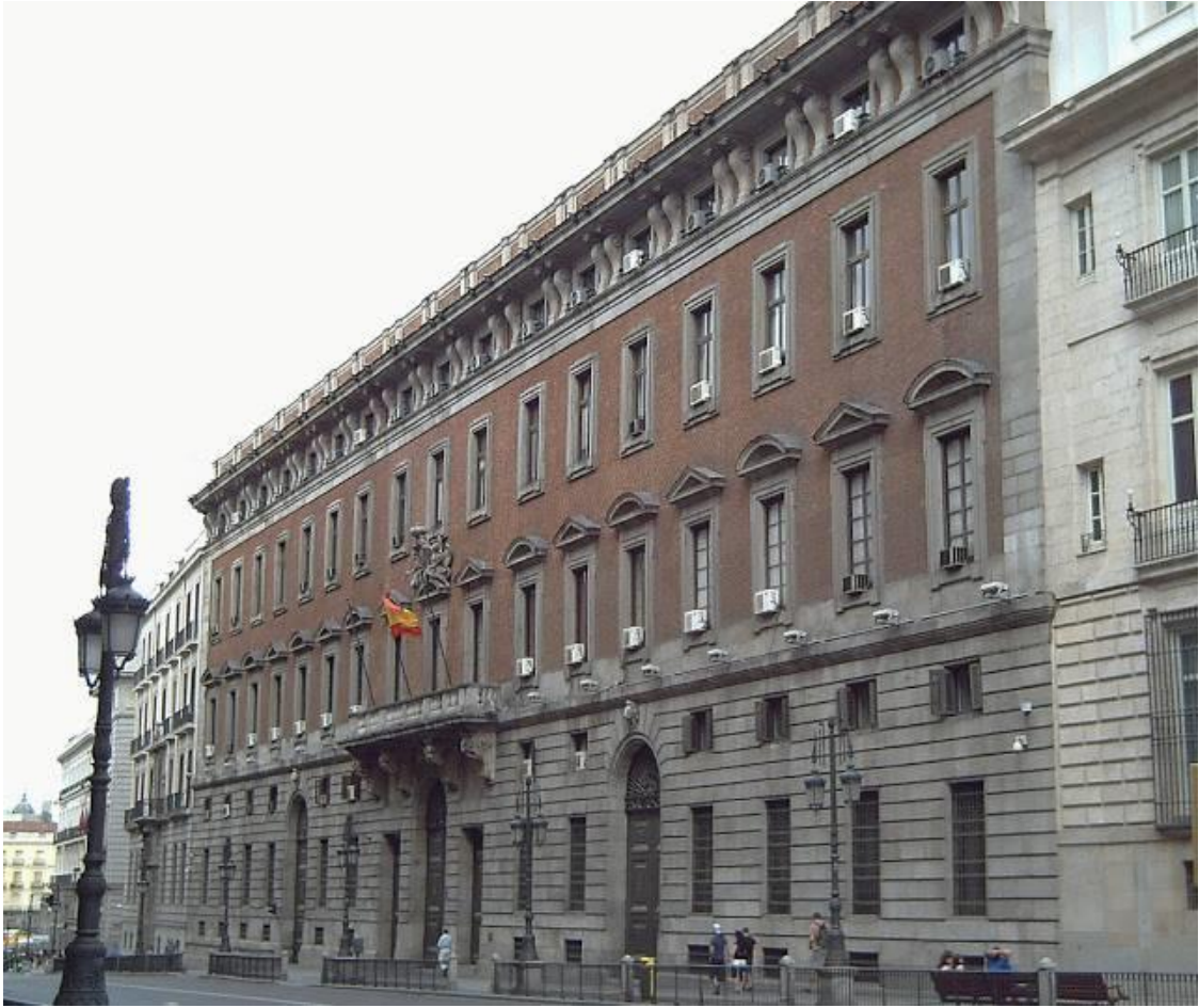
Fachada de la calle de Alcalá de la antigua Aduana de Madrid.
