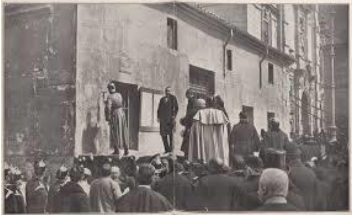
El rey Alfonso XIII iniciando el simbólico derribo de la llamada "casa del cura" de la iglesia de san José señalando el comienzo de las obras de la futura Gran Vía madrileña.
