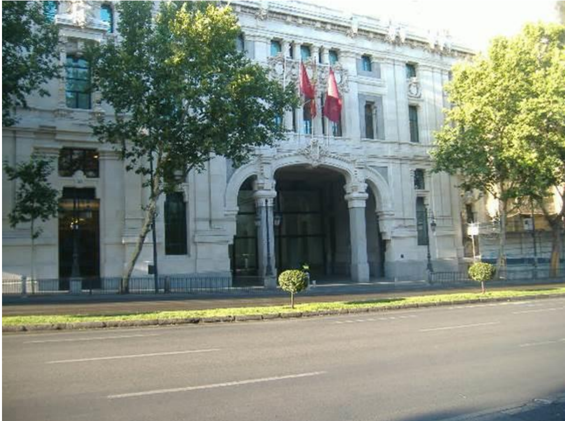
Fachada lateral del Palacio de Comunicaciones correspondiente a la linde de la manzana prevista fijada por la calle de Alcalá.
